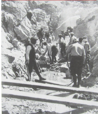
▲困難を極めた開削工事
