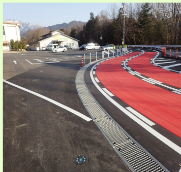
マーカー塗装された出入口
