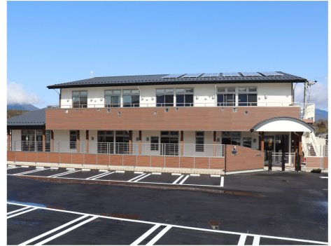
2階建ての新しい園舎
