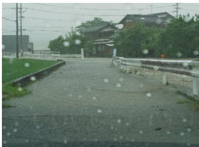
麦搗川周辺市道冠水(室屋)
