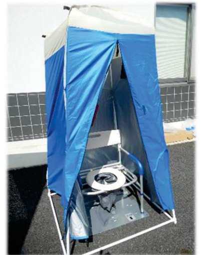
災害用マンホールトイレ設置 (苗木交流センター)
