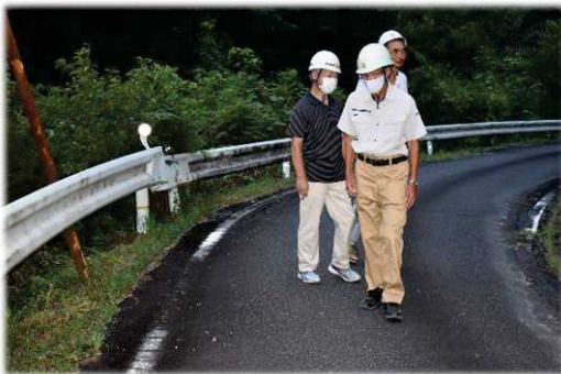
危険個所の点検
