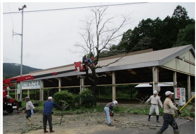
伐採作業の様子
