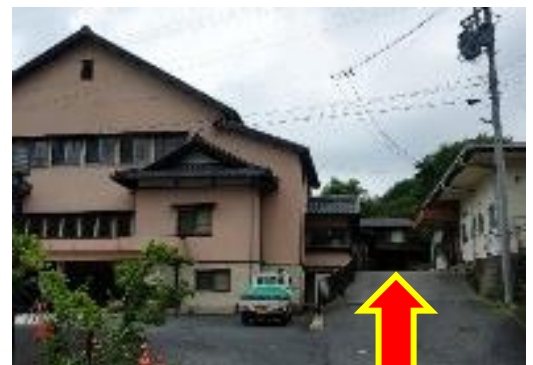
避難所の入口は、南側の玄関になります
