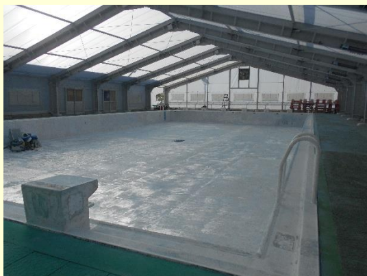
【プール缶体再塗装】 古い塗装の剥がし作業が完了
