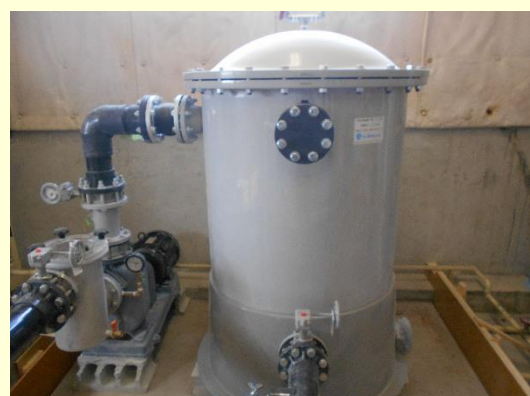
【ろ過機取替え】 約40年ぶりの新品ろ過機
