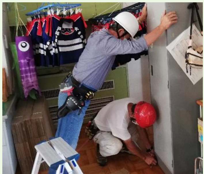
保育室のロッカー固定作業を行う、ふくおか地区の防災士の方々
