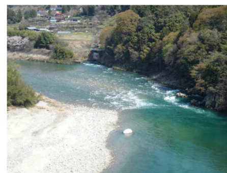
↓ 山口発電所放水口
