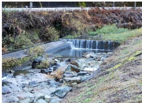
外洞川字井汲地内の取水口。河床が下がり川右岸に新しく作られた。かつては100メートルほど下方左岸で取水していた。
