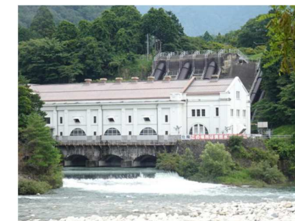
↑現在の賤母発電所
