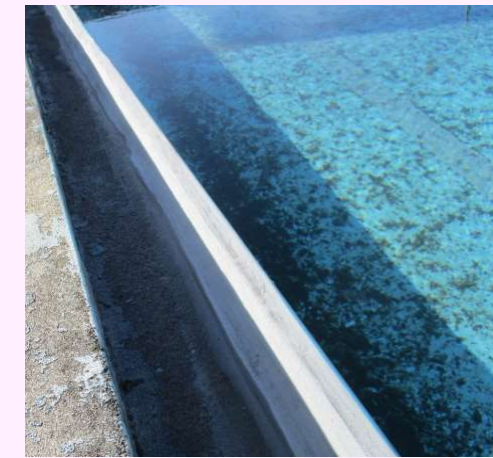
▲プールサイドの樹脂劣化を補修
