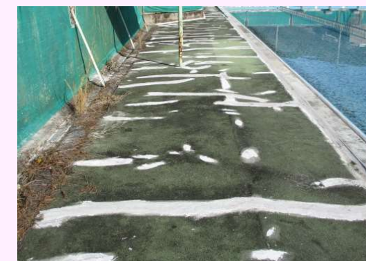
▲通路のひび割れを補修
