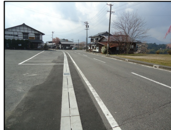
【中津川南木曾線 道路側溝敷設替】 (馬籠地域)
