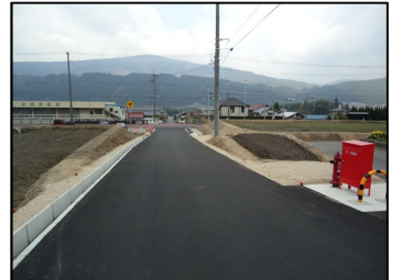
【青木平地区ほ場整備及び市道取替工事】 (第2町内会)
