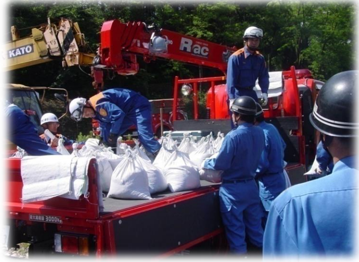
↓土のうを作り、積み込む消防団員(水防工法訓練)↑
