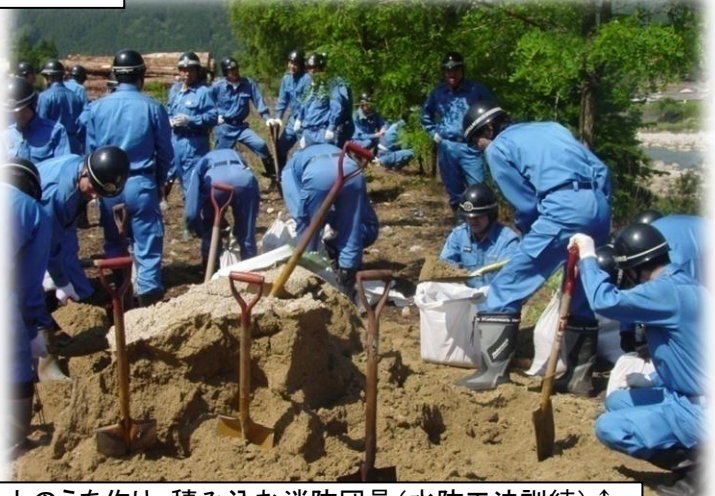
↓土のうを作り、積み込む消防団員(水防工法訓練)↑
