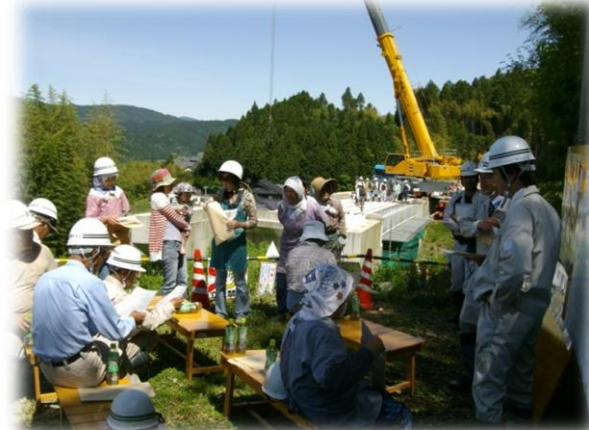
現場での説明会 工事費の話が一番盛り上がりました
