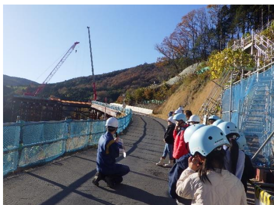
▲第一木曾川橋りょう工事現場見学
