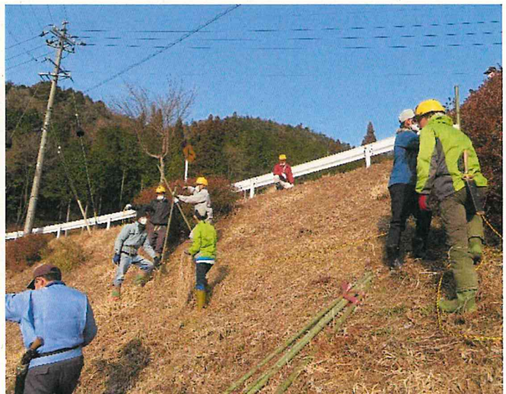
みやさか植樹事業の準備支柱配置作業 3/5.
