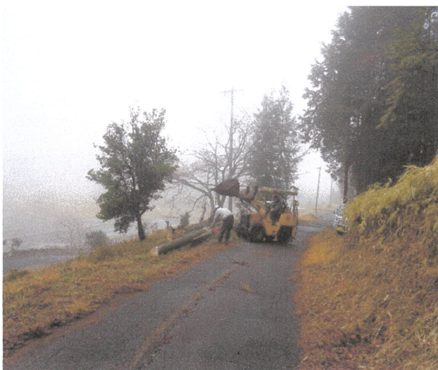
* 伐採木の引き上げ作業
