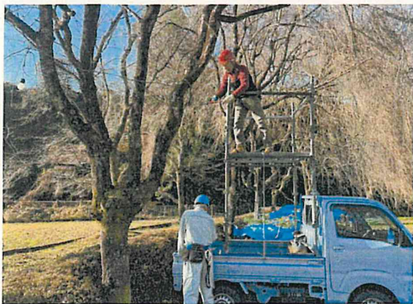
旧電線撤去作業
