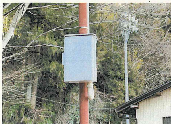
新設 分岐BOX設置
