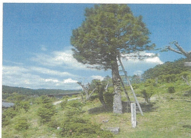
高木撤去作業
