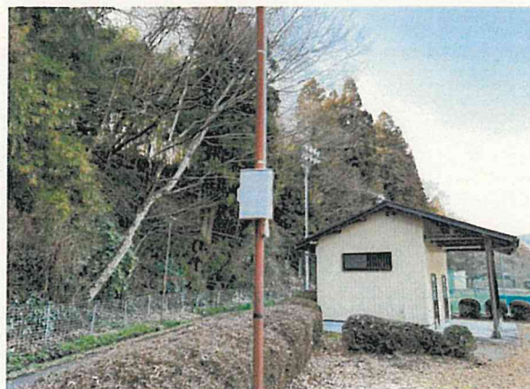
新設 分岐BOX設置
