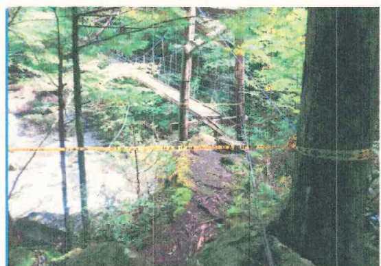
通行止めした一ツ滝手前の吊り橋
