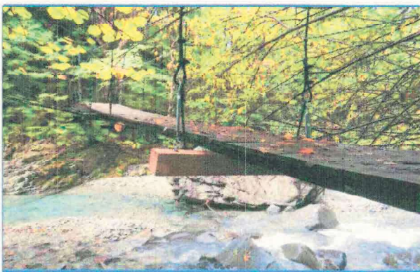
仮修復した吊り橋
