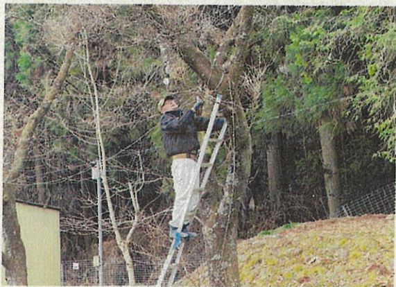
旧電線撤去作業
