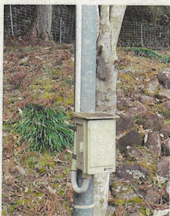
新設 分岐BOX設置
