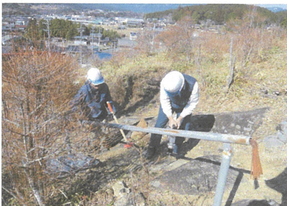
2箇所目工事着工(R7.3.1)
