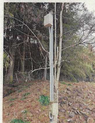
新設 分岐BOX設置
