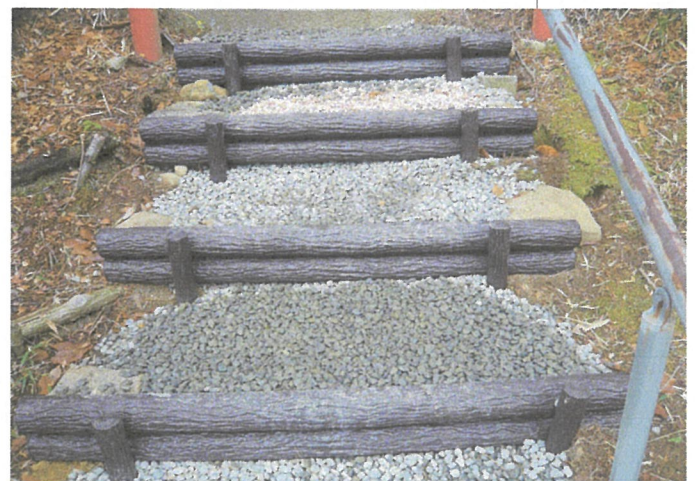
工事完成(R6.12.9)
