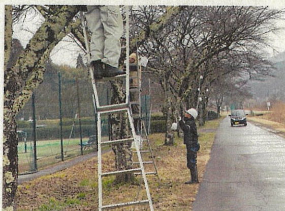
コバエ撤去 チッパー作業
