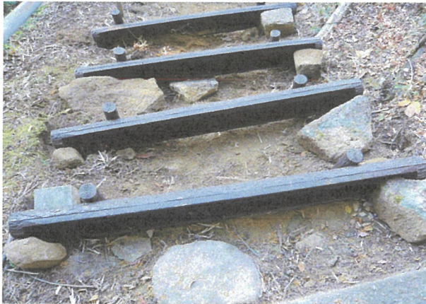
仮枠設置(R6.12.6)
