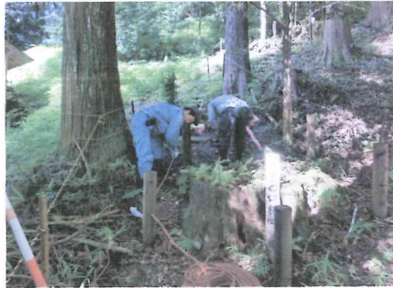
防護柵の設置工事
