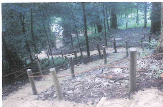
完成した散策路
