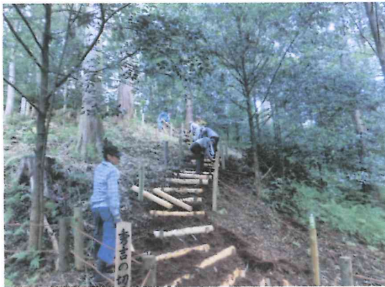
散策路の階段と手すり設置工事
