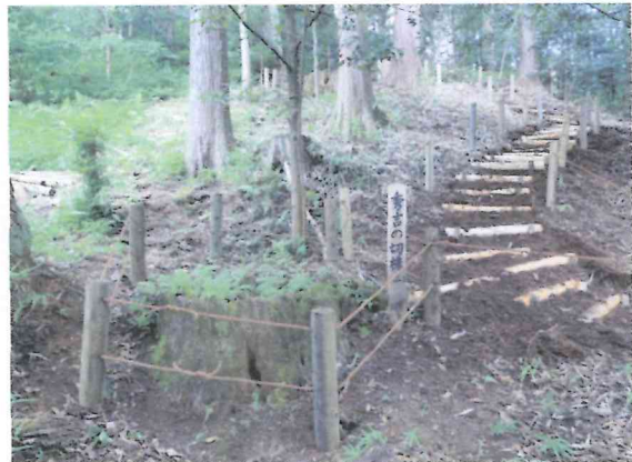
完成した防護柵
