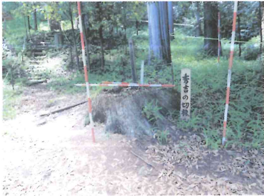
保存工事前の切り株と旧散策路
