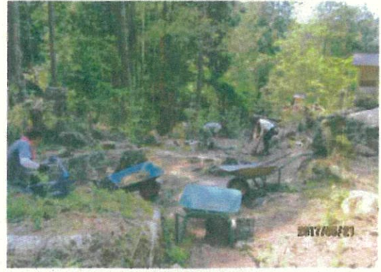
竜神社遊歩道修繕作業
