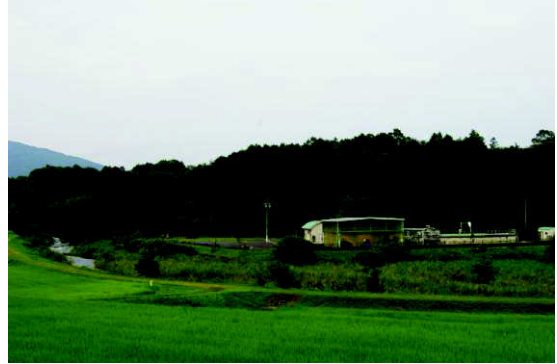
◆北部浄化センター
