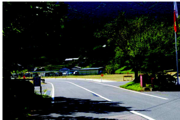
▲平成22年に完成した「市道鳩吹～町切線」
