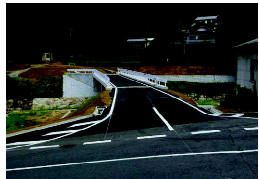
◆平成22年完成した「立壁橋」【棚田地内】
