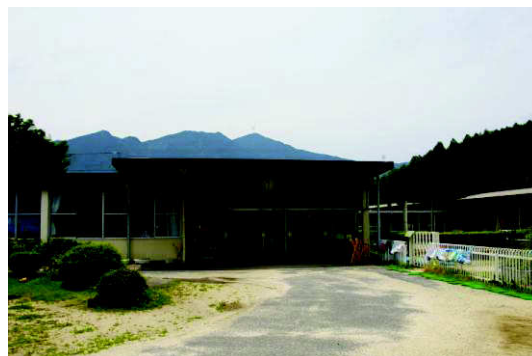
◆早期改修が望まれる蛭川保育所
