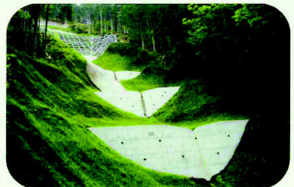
猪の谷治山堰堤
