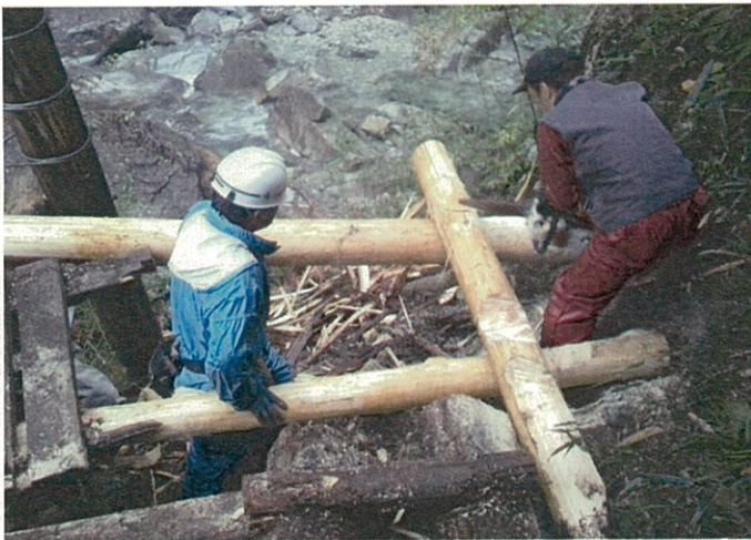
登山道吊橋修繕作業中
