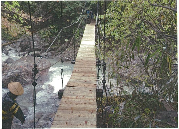
登山道吊橋修繕完了
