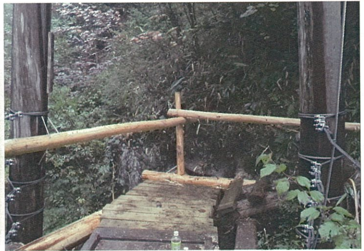
登山道吊橋修繕完了
