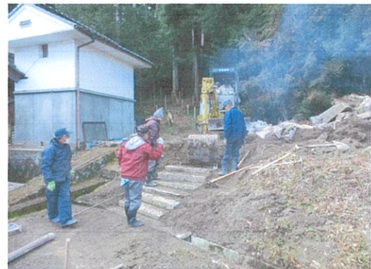
重機を使った掘削や石の運搬
