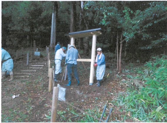
説明板の設置作業
