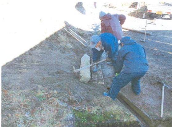
御影石の階段設置
