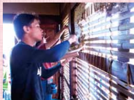
木匠塾の取り組みで古民家改修で土壁を塗る学生
