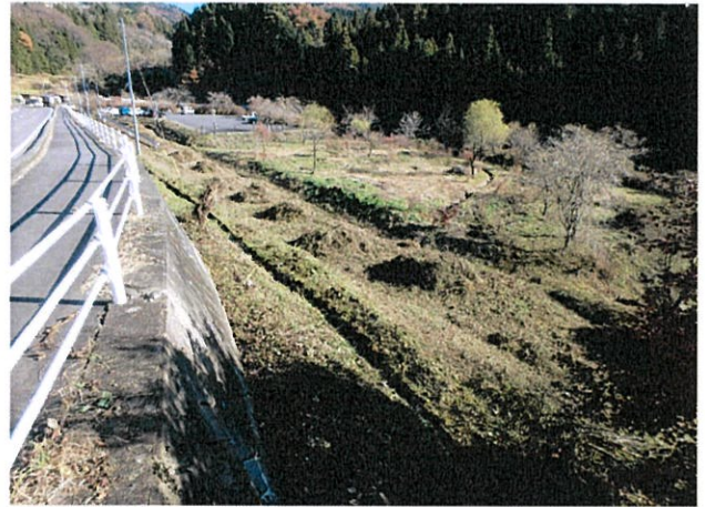
伐採作業完了
