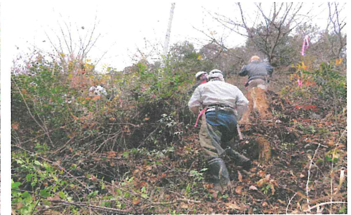
マス池上の急斜面での雑木除去作業
