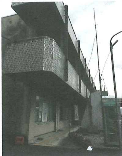
支部局固定アンテナ設置
