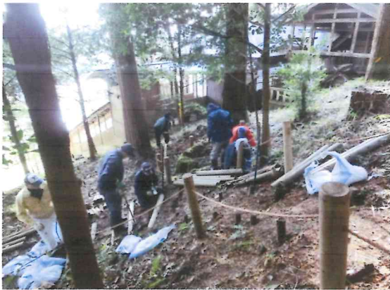
散策路の階段の取り換え(1)
