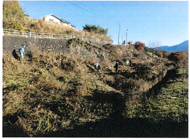
植栽地伐採作業中
