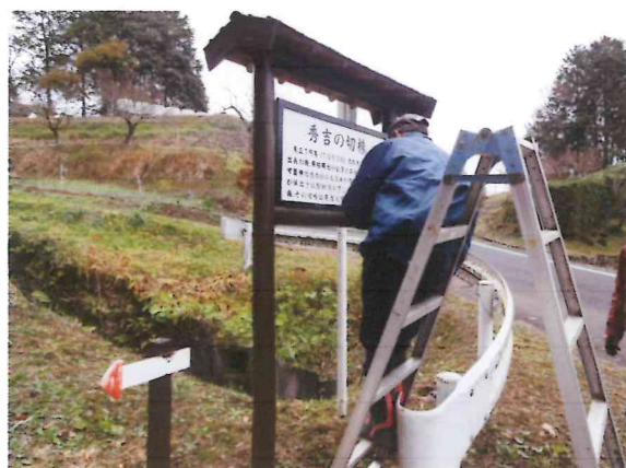
新しい説明板の取り付け作業
