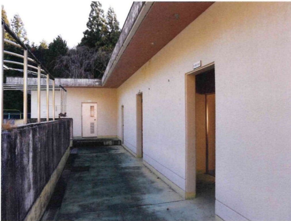
プール管理棟
