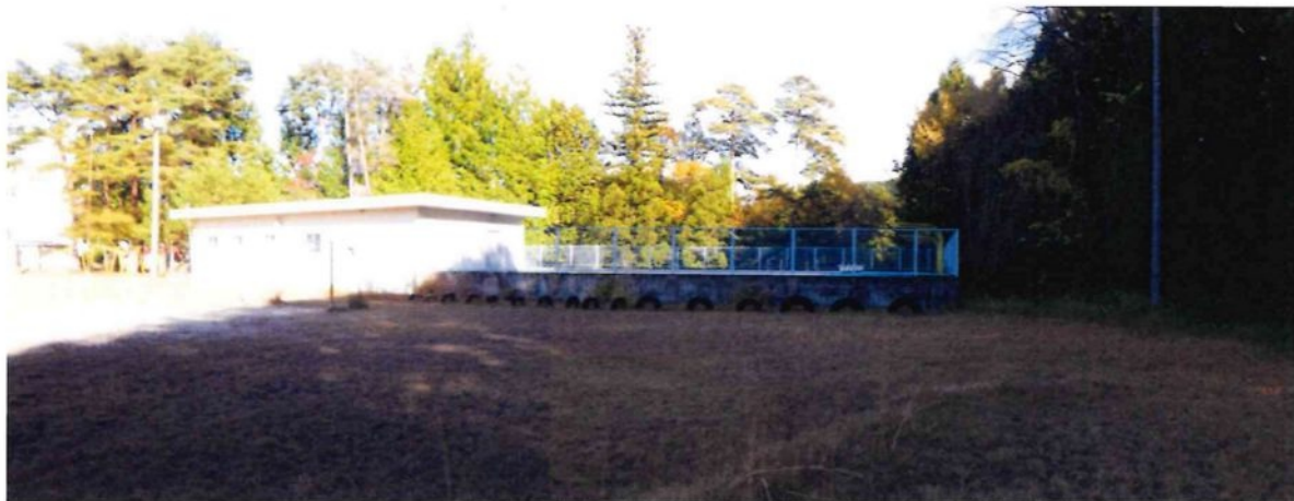
プール管理棟
