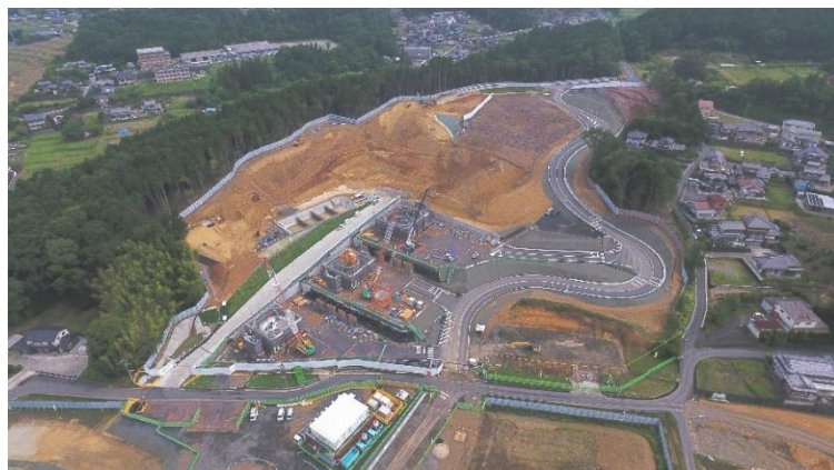
【工事が進むリニア中央新幹線 岐阜県駅予定地】
