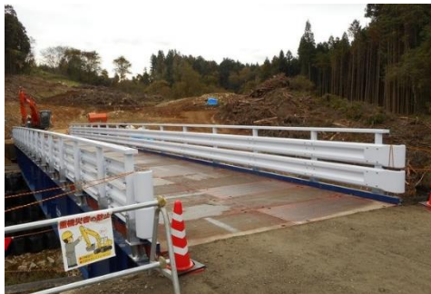
工事用仮設橋
