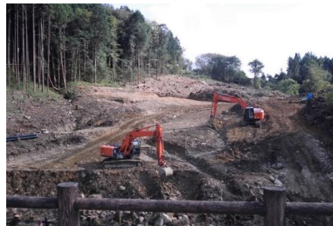
工事現場の様子
