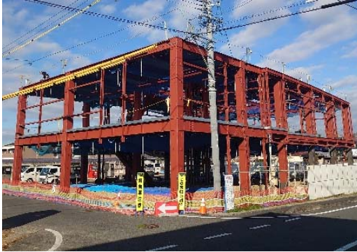
東濃5市消防指令センター建設状況
