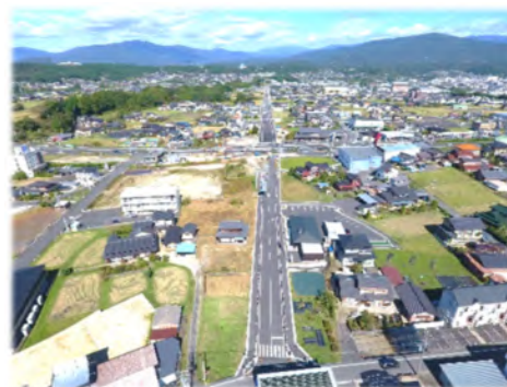
工事の様子（手賀野地内から）
