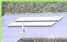
(太陽光発電設備)
