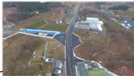
市道坂本58号線他 工事の様子 (株)クマガイ様付近 令和4年度施工延長 L=240m
