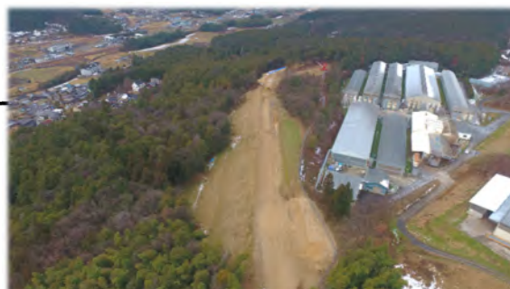
東濃東部都市間連絡道路 工事の様子 (株)ダイシンエッグ様付近 令和4年度施工延長 L=600m
