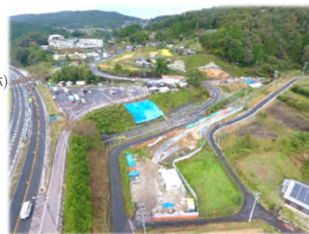
工事の様子（神坂PA上り線付近）
