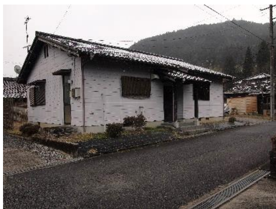
坂下医師住宅 （令和3年度再編予定施設）
