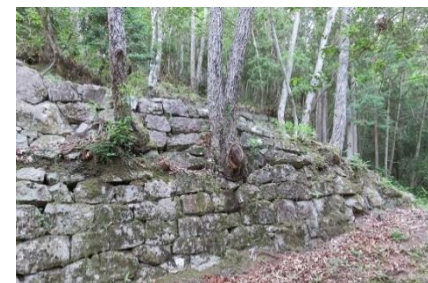
修復予定の苗木城跡大手口道石垣
