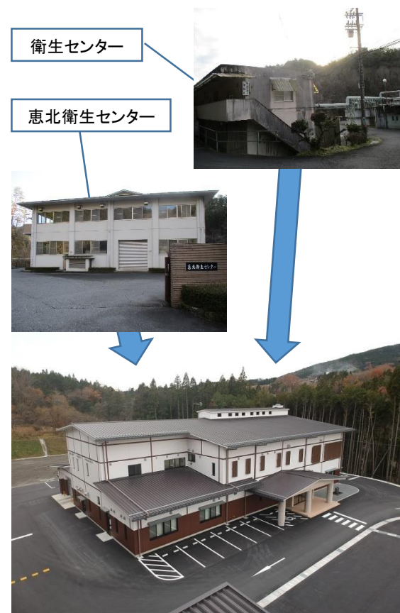
汚泥処理センター「アクアクリーン中津川」
