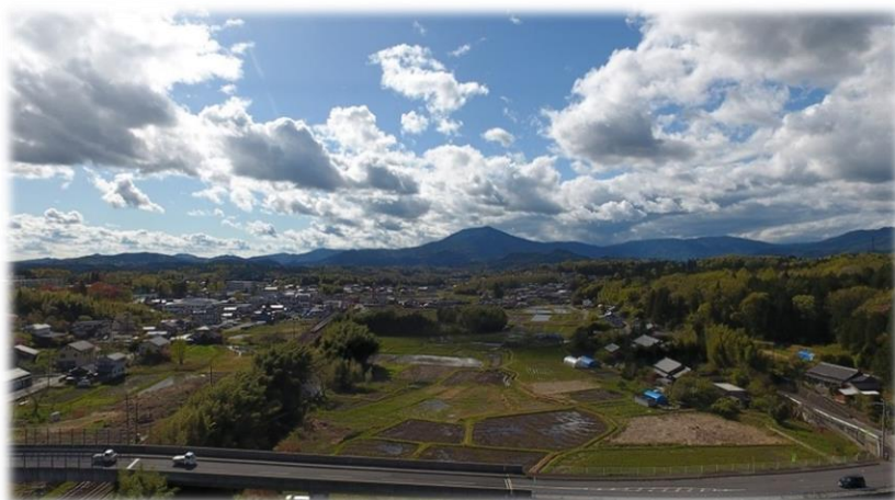
リニア中央新幹線岐阜県駅予定地
