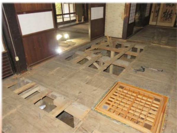
※① 落合宿本陣の補修の様子
