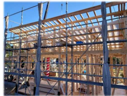
※③ 地元産材を用いた市内での 住宅の取得（新築）の様子
