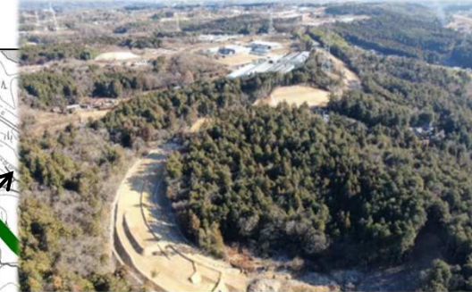
※③ 東濃東部都市間連絡道路工事の様子
