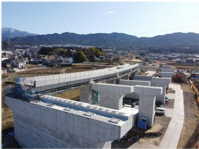
※① 濃飛横断自動車道整備の様子
