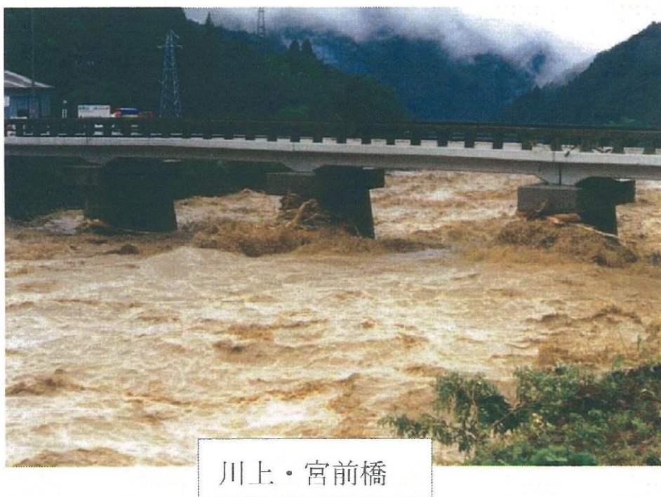
図 3-6 平成 12 年 9 月 11 日～12 日の東海豪雨時の宮前橋の様子
