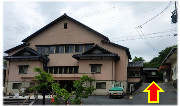
避難所の入口は、南側の玄関になります
