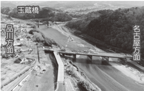
第二木曽川橋りょう(令和7年1月現在)
