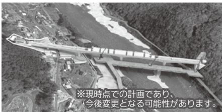
第二木曽川橋りょう(施工イメージ)
