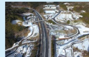
道路新設改良事業（神坂スマートインターチェンジ）
