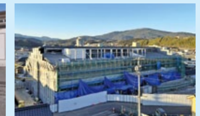
中心市街地活性化拠点整備事業（ひと・まちテラス）
