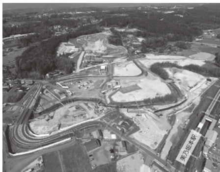
リニア岐阜県駅(仮称)建設工事などの状況 (5月17日撮影)
