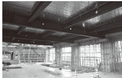
▲3階 調理室・木育ひろば・テラス部分
