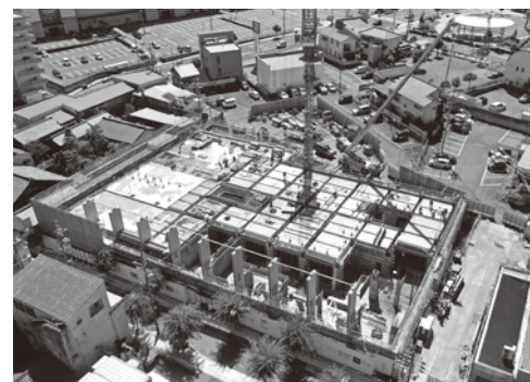
▲工事現場の様子（7月29日現在）
