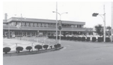
昭和53年 新築された中津川駅
