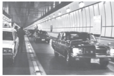
昭和50年 恵那山トンネル開通直後のトンネル内
