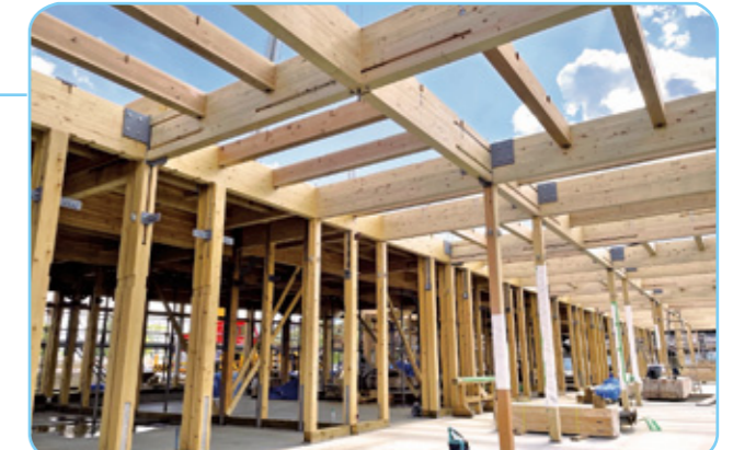
校舎の建て方工事の様子（6月14日） 福岡地区
