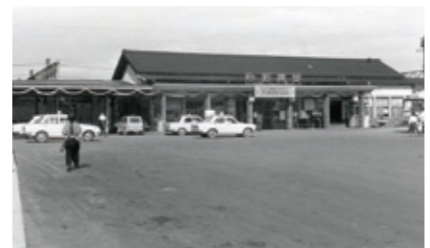
昭和28年 改修された中津川駅（昭和43年頃撮影）
