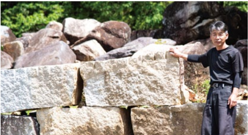
苗木城の石垣修復に使う岩のストック
