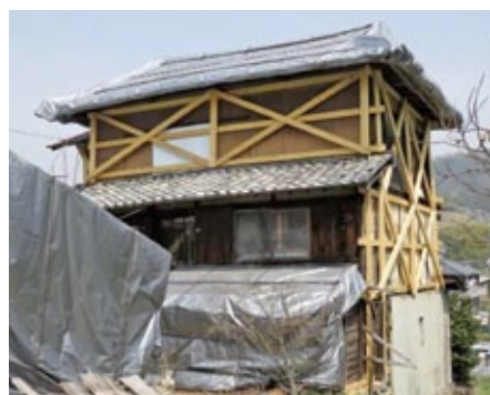
▲シートや補強材に覆われた離れ
