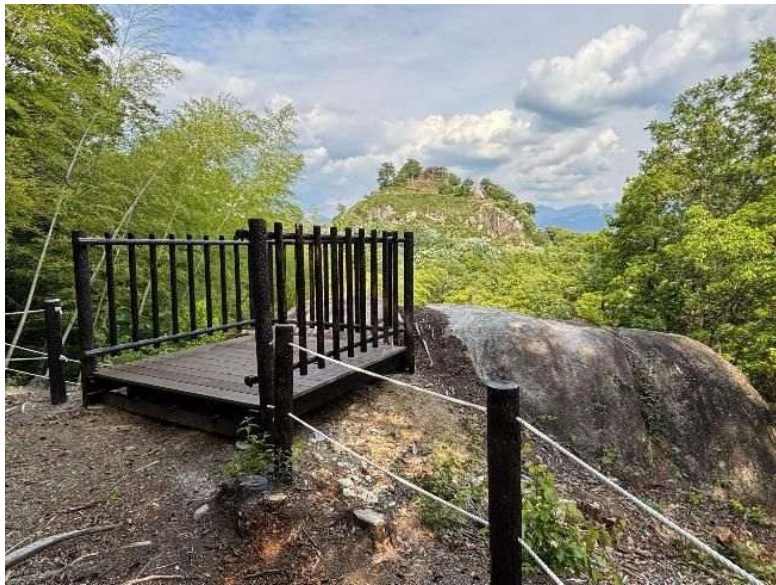
第1号ビュースポットデッキ
