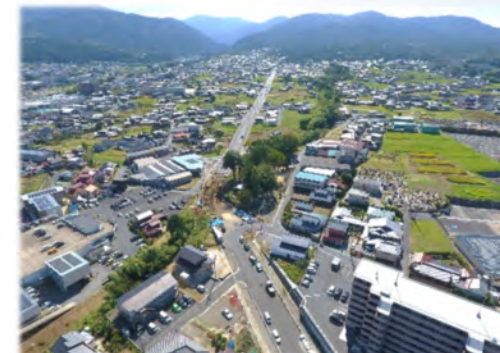
工事の様子（青木交差点付近から）
