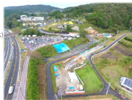
工事の様子（神坂PA上り線付近）
