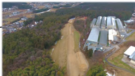
東濃東部都市間連絡道路 工事の様子 (袷ダイシンエッグ様付近) 令和4年度施工延長 L=600m
