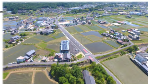
市道坂本264号線 工事の様子 (源長寺様付近) 令和4年度施工延長 L=410m
