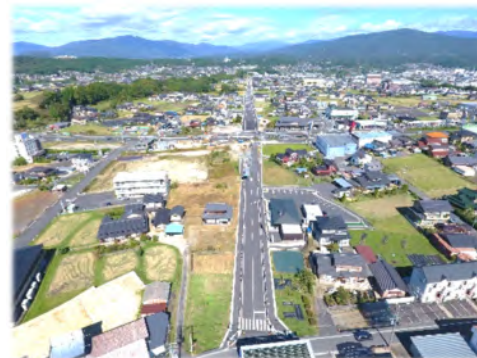
工事の様子（手賀野地内から）
